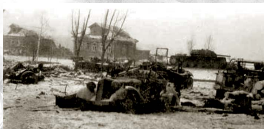
4–5 декабря 1941 г., деревня Горки после освобождения от фашистов
